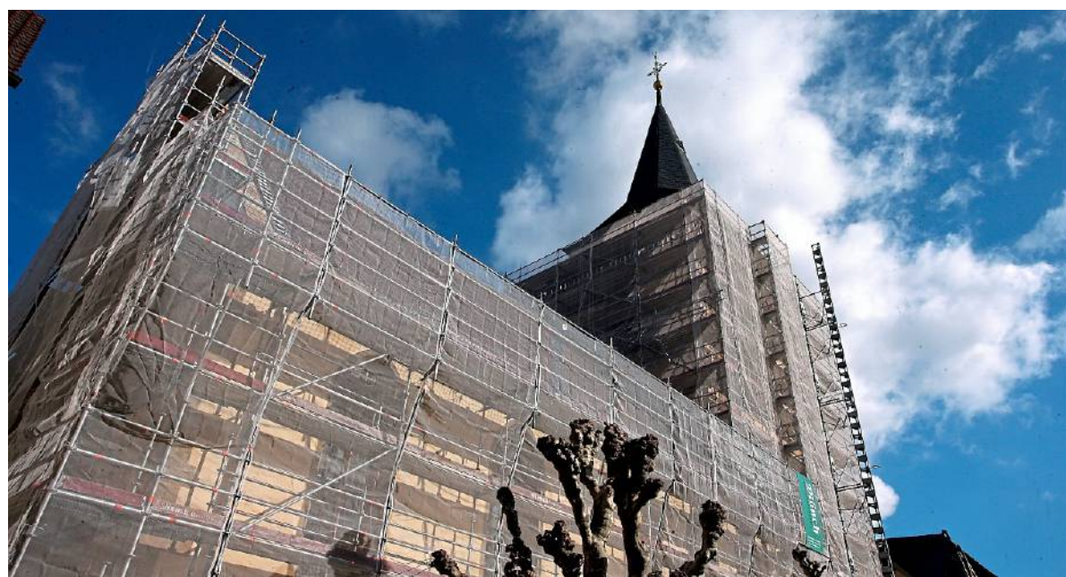
Die evangelische Stadtkirche Großsachsenheim wird derzeit umfassend saniert.
