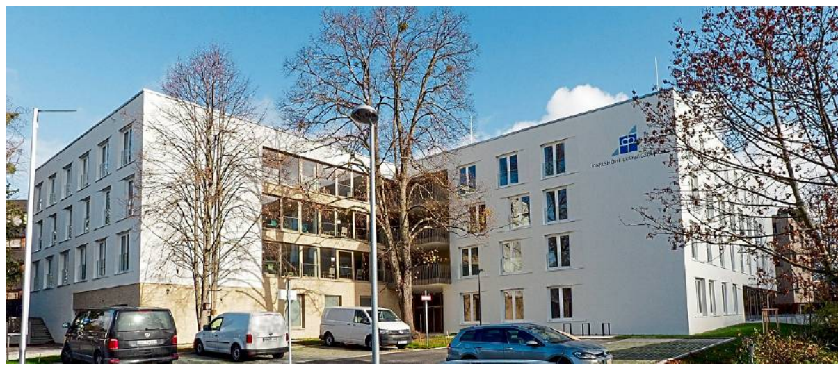
Das neue Haus am Salon der Stiftung Karlshöhe ist fertig, in der Konsequenz steigen die Preise. Foto: Holm Wolschendorf
