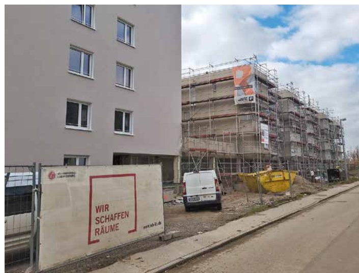
Die WBL baut, vermietet und verkauft die neuen Wohnungen. (Foto: WBL)
