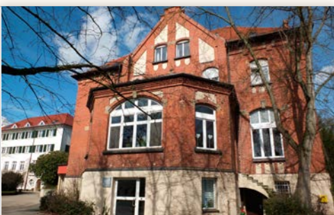
1901 erbaut: Verwaltung und Speisesaal
